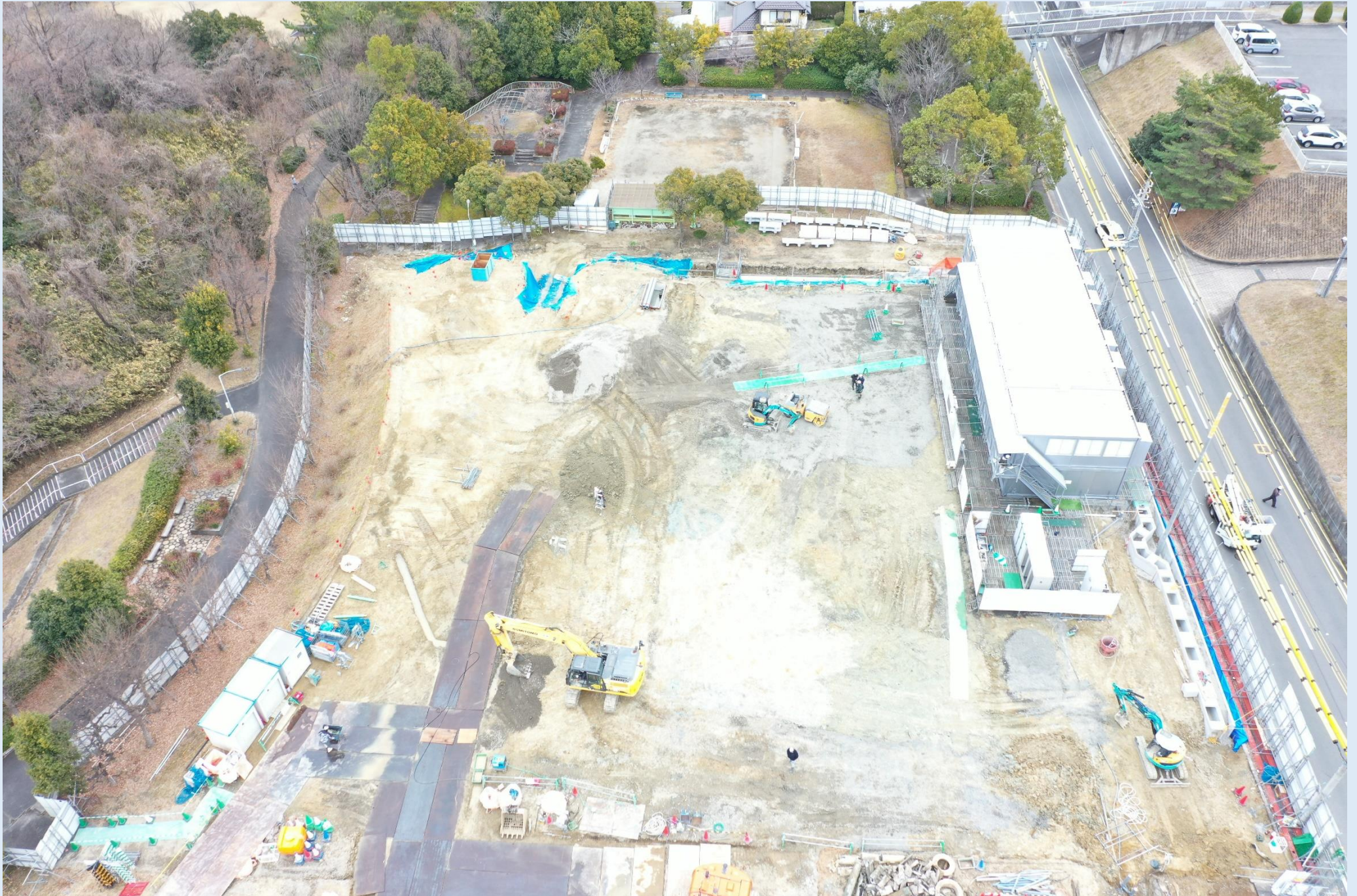
開発工事状況 (R6.1)
