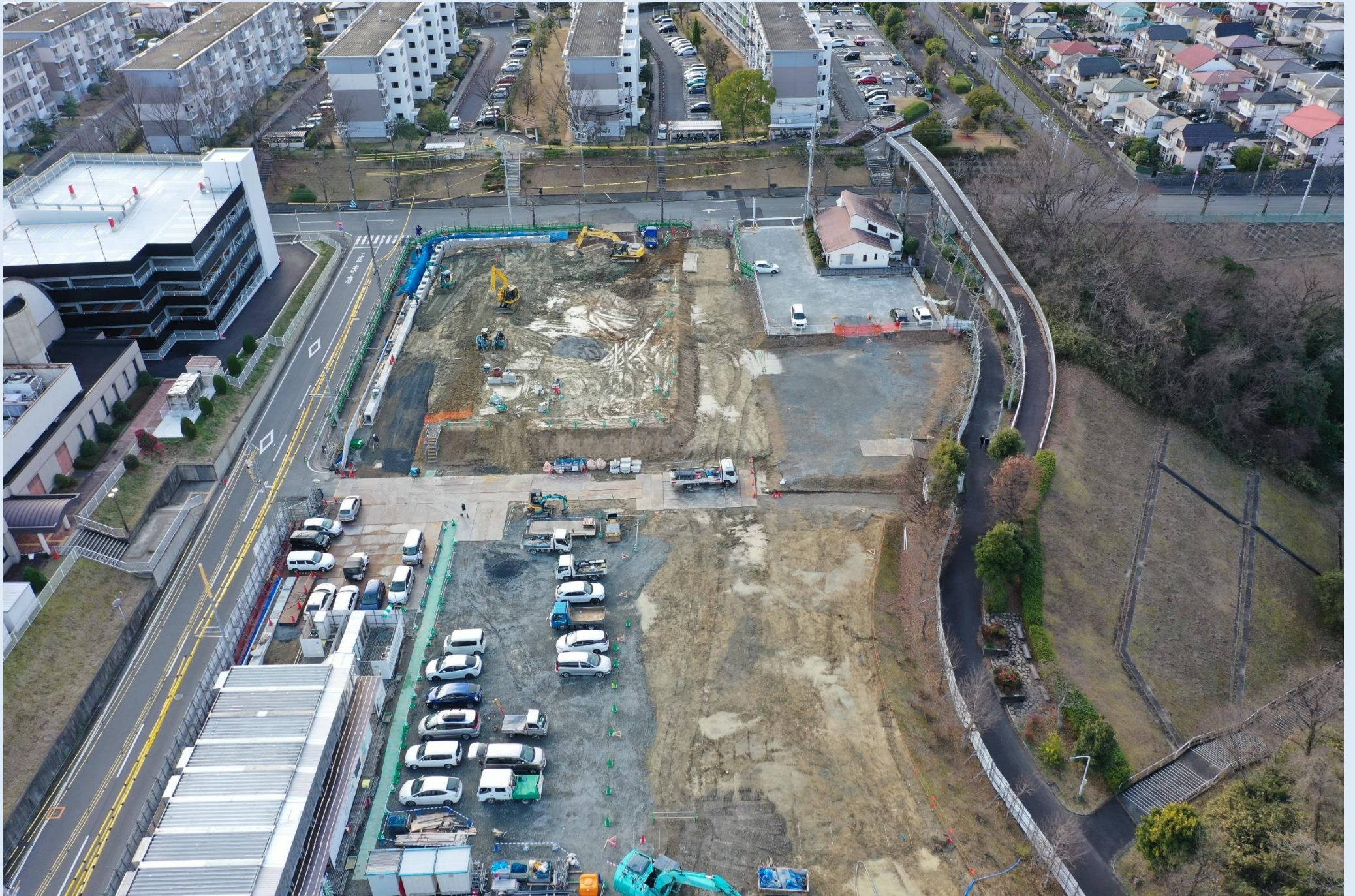
開発工事状況 (R6.2)
