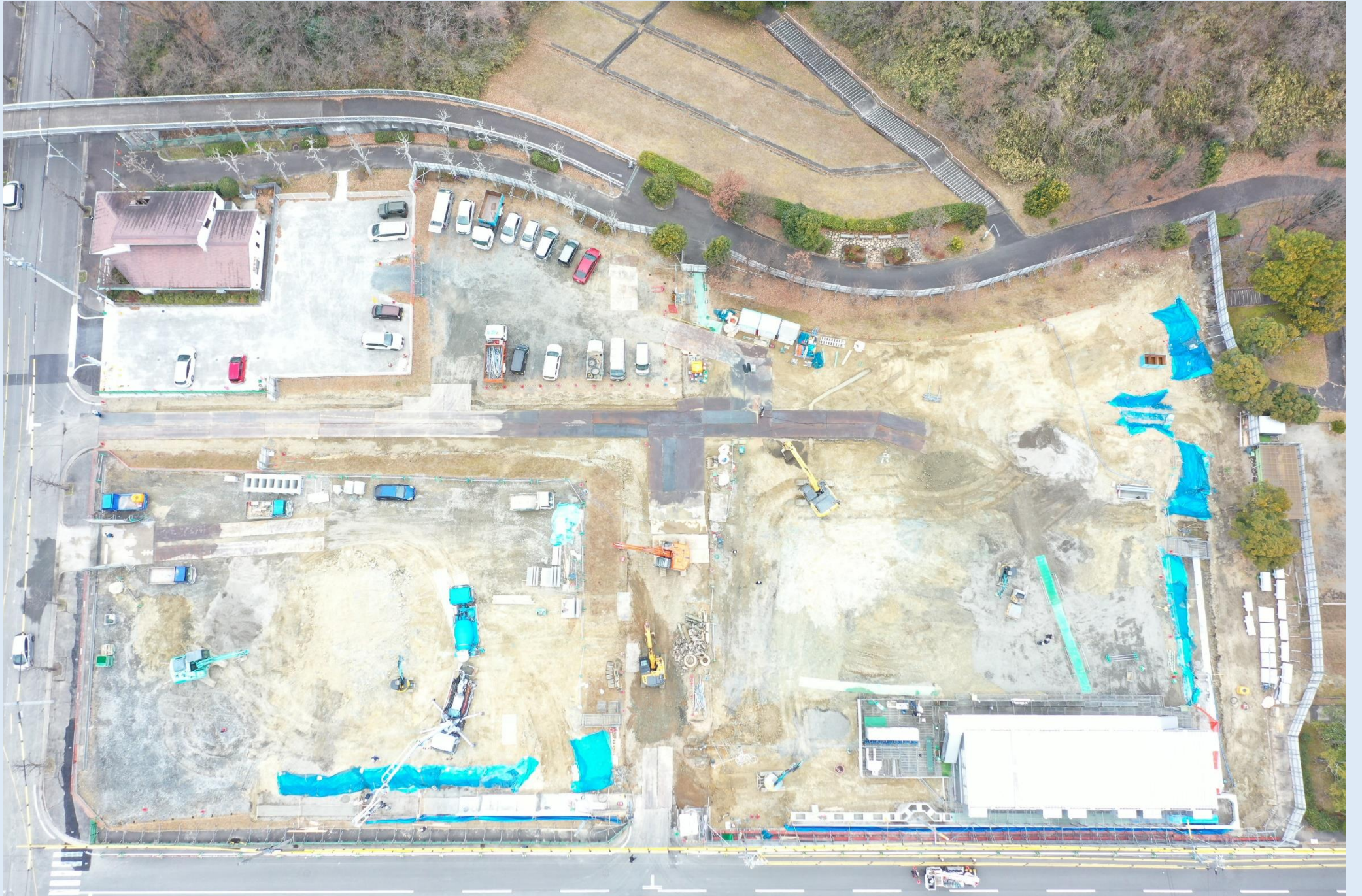
開発工事状況 (R6.1)
