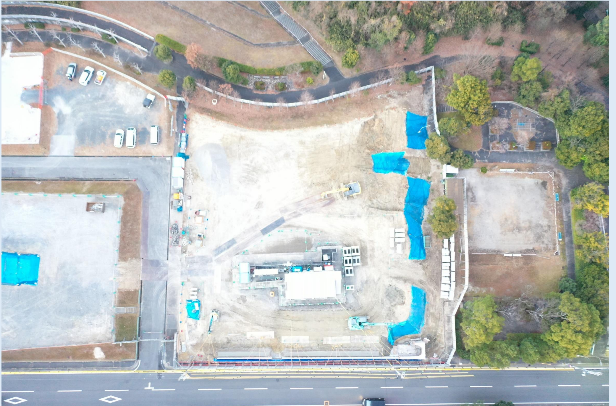
開発工事状況 (R5.12)
