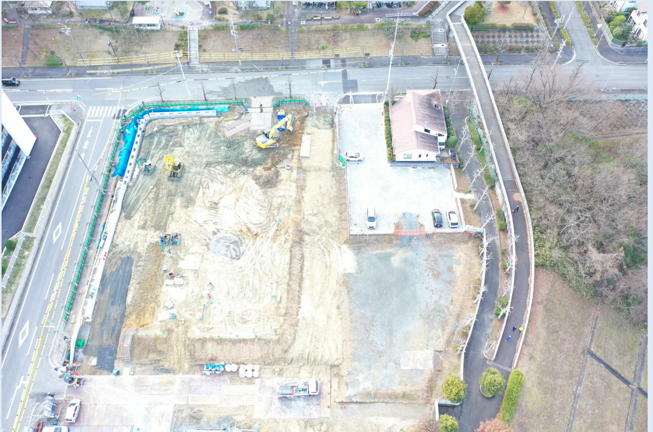
開発工事状況 (R6.2)
