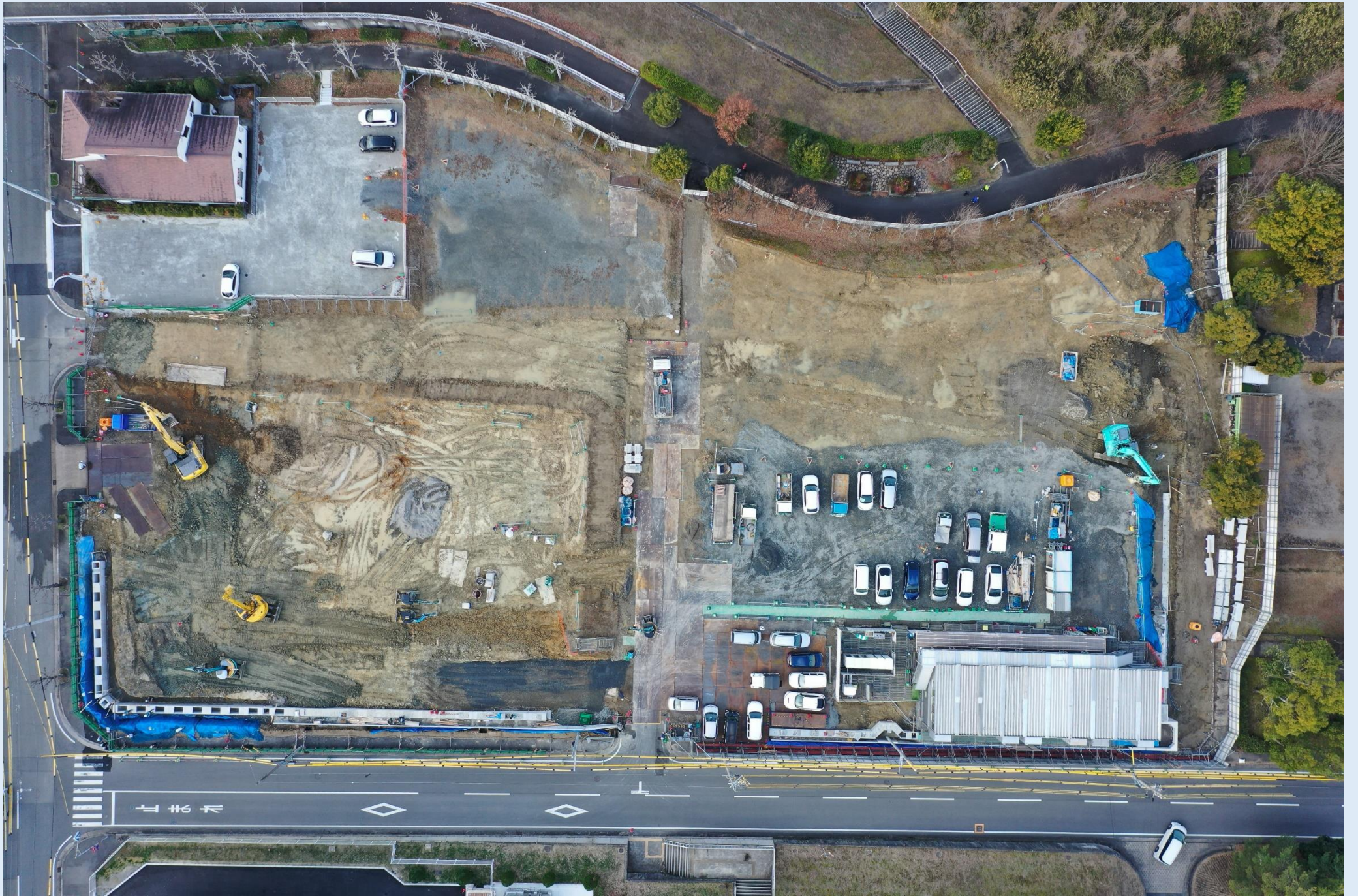
開発工事状況 (R6.2)
