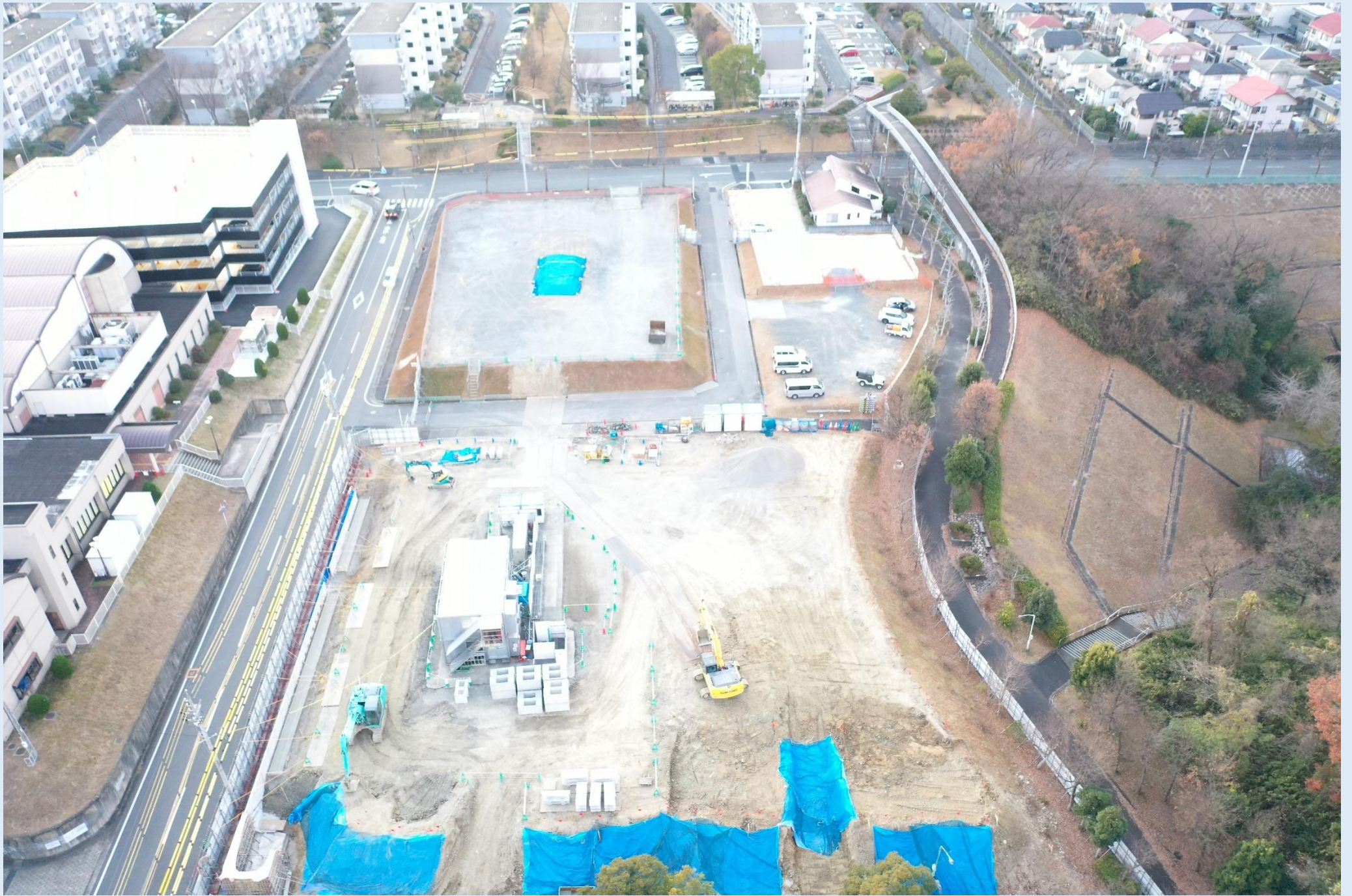
開発工事状況 (R5.12)
