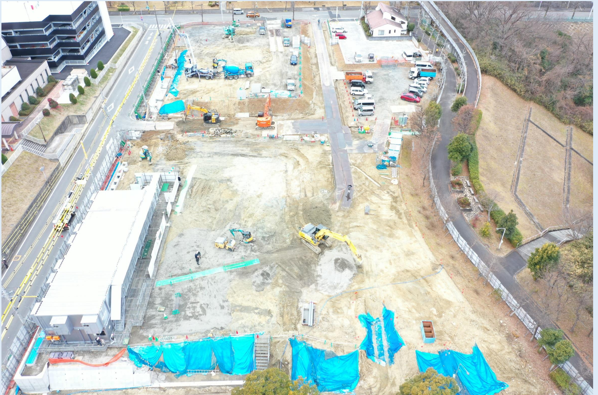
開発工事状況 (R6.1)
