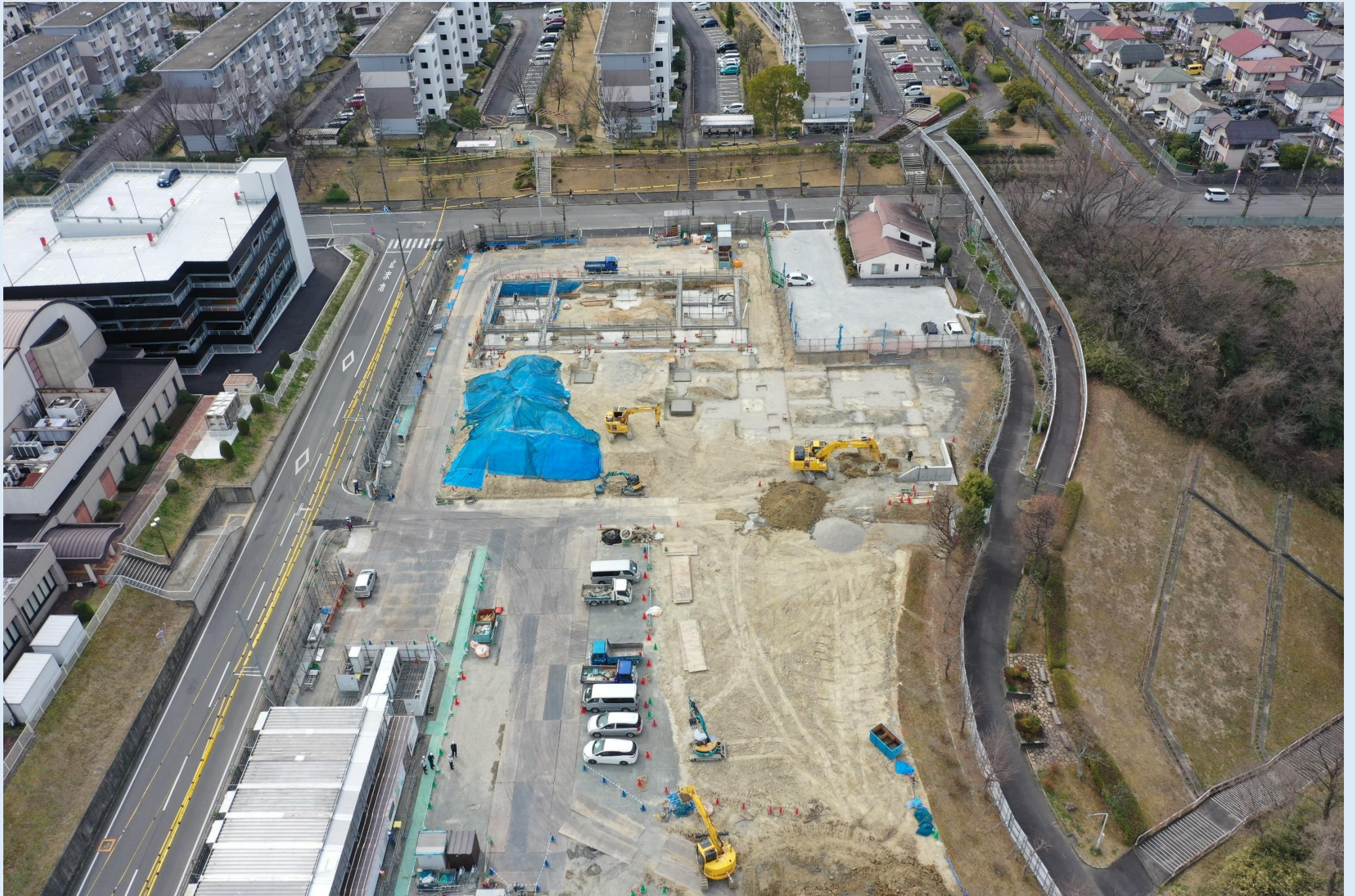
基礎工事状況 (R6.3)
