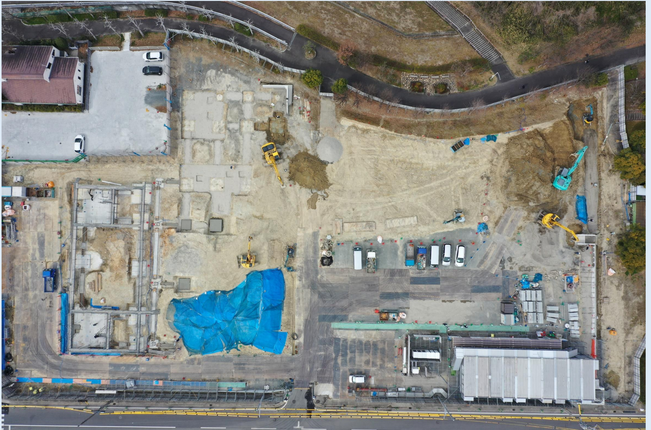
基礎工事状況 (R6.3)
