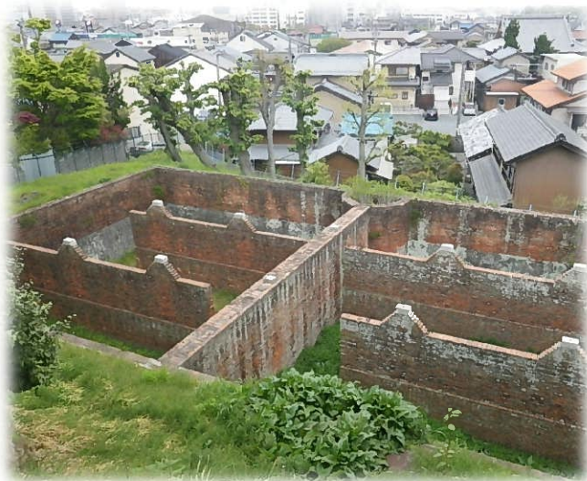
諸戸水道遺構 明治37年（1904）竣工 （貯水池：容量 925m 3 、湧水量約 900m 3 /日）
