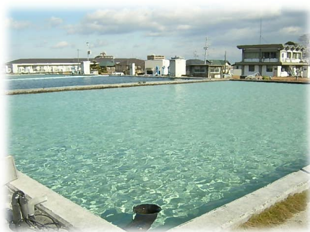
上野浄水場 昭和45年（1970）竣工 （緩速ろ過池：浄水能力 10,000m 3 /日）
