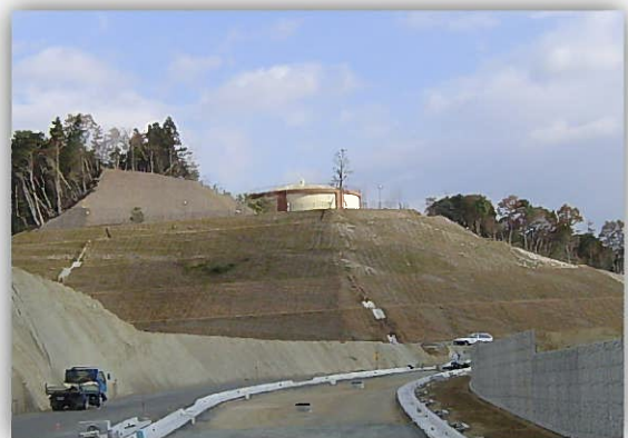
多度北部配水場昭和59年(1984)竣工
