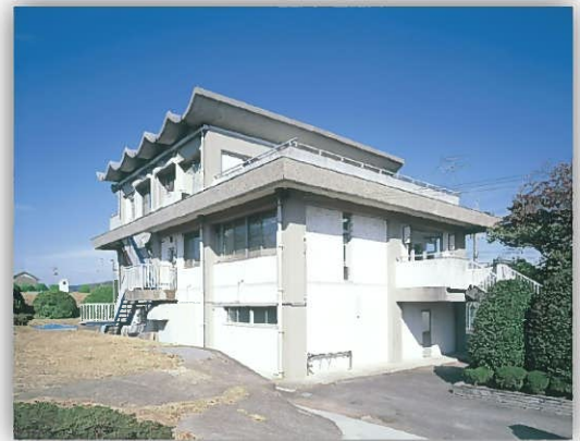
上野浄水場管理本館
