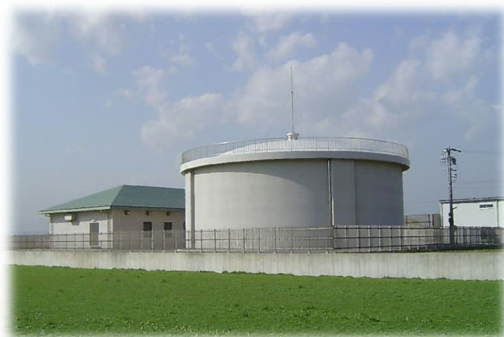
白鷄配水場 平成14年（2002）竣工 （PC配水池：有効容量 2,000m 3 ）
