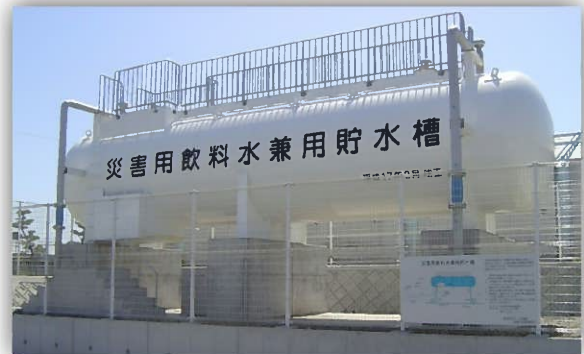
長島地区災害対策用貯水槽
