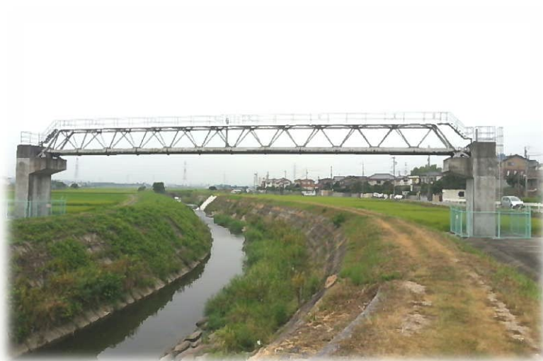
弁天川水管橋 平成13年（2001）竣工 （西部水源地から大山田配水場へ）
