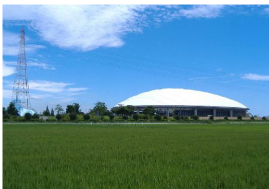
国営木曾三川公園施設と田園景観
