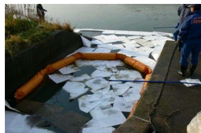
高圧洗浄の様子。
