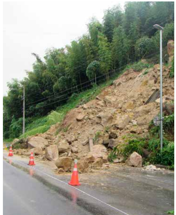
昨年の台風16号による額田市内の土砂災害
