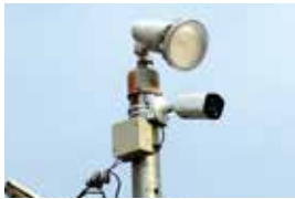
公園に設置した防犯カメラ
