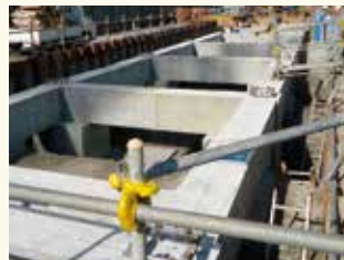
⑤ 地中梁（脱型後）
