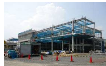
④南東より
