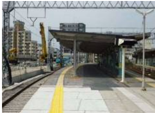
①近鉄上りホーム拡幅部 上屋設置
