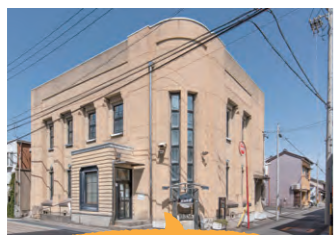
アールデコ様式の鉄筋コンクリート造り
