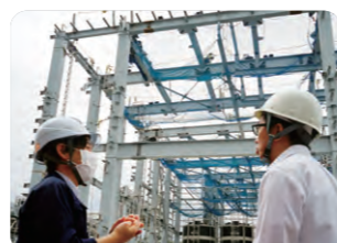
きれいな水を作る施設を建設中
