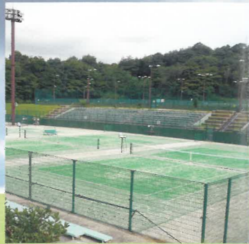
テニスコート 透水性砂入り人工芝16面(夜間照明有り) 練習コート(壁打ち)1面 多目的コート(バスケットボール・バレーボール)1面
