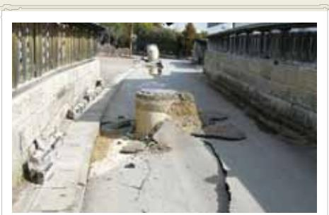
●液状化によるマンホールの被害状況
