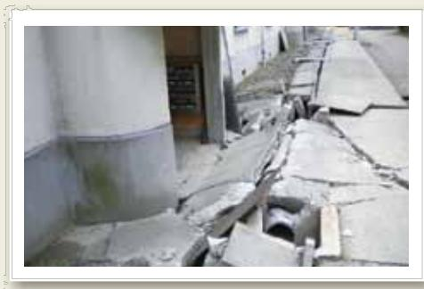
●液状化による建物、道路の沈下状況
