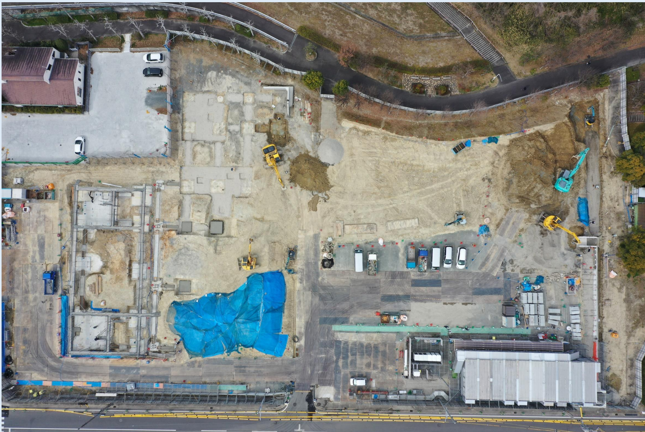
基礎工事状況 (R6.3)
