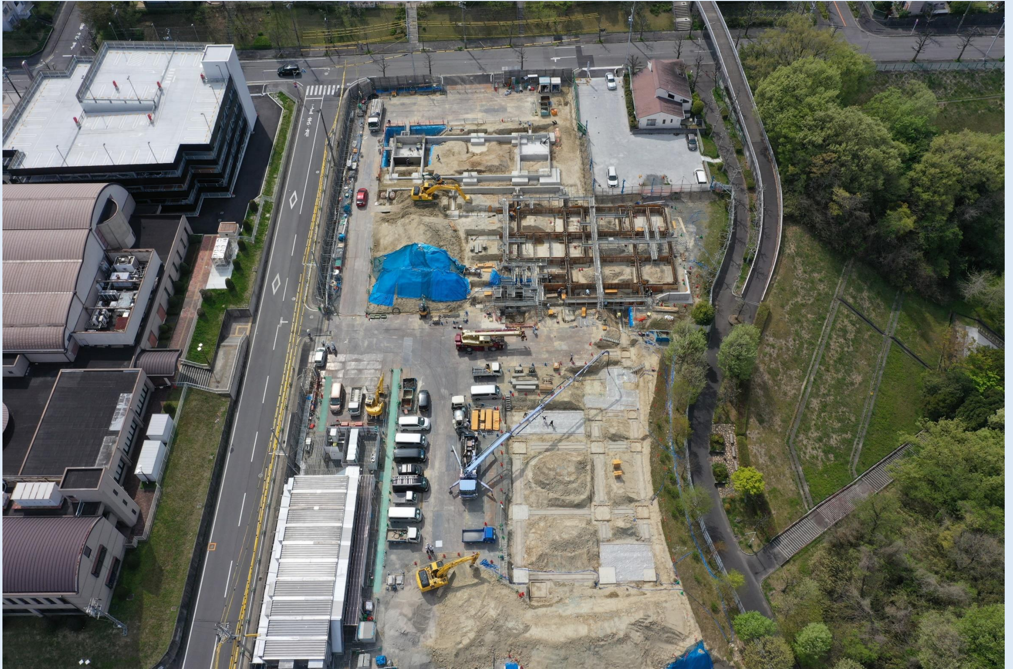
基礎工事状況 (R6.4)
