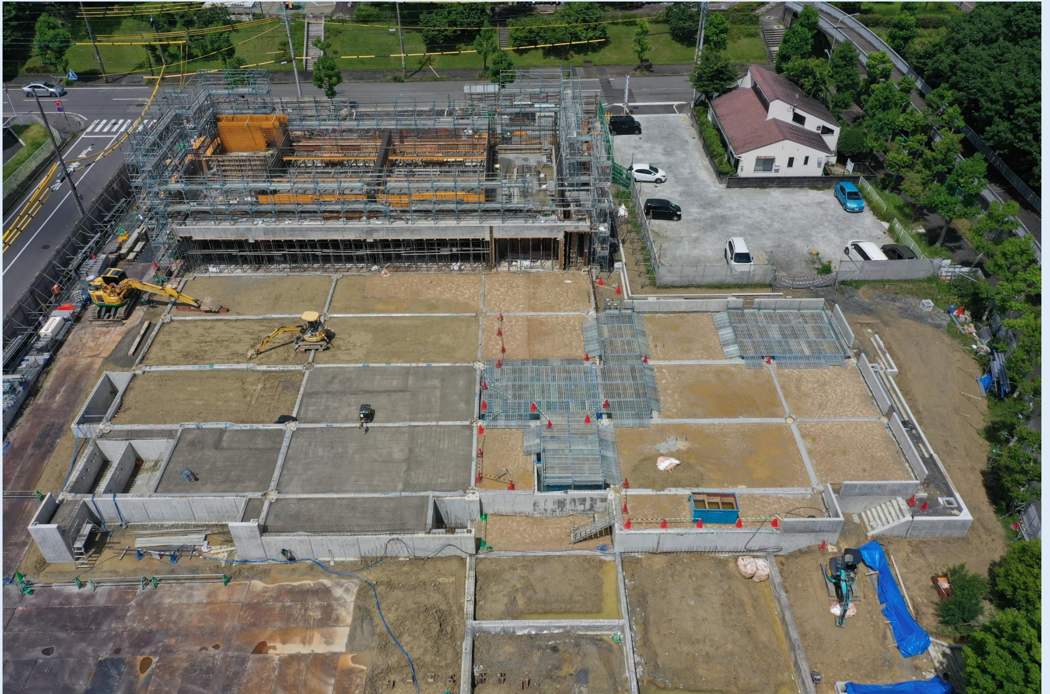
基礎工事状況 (R6.6)
