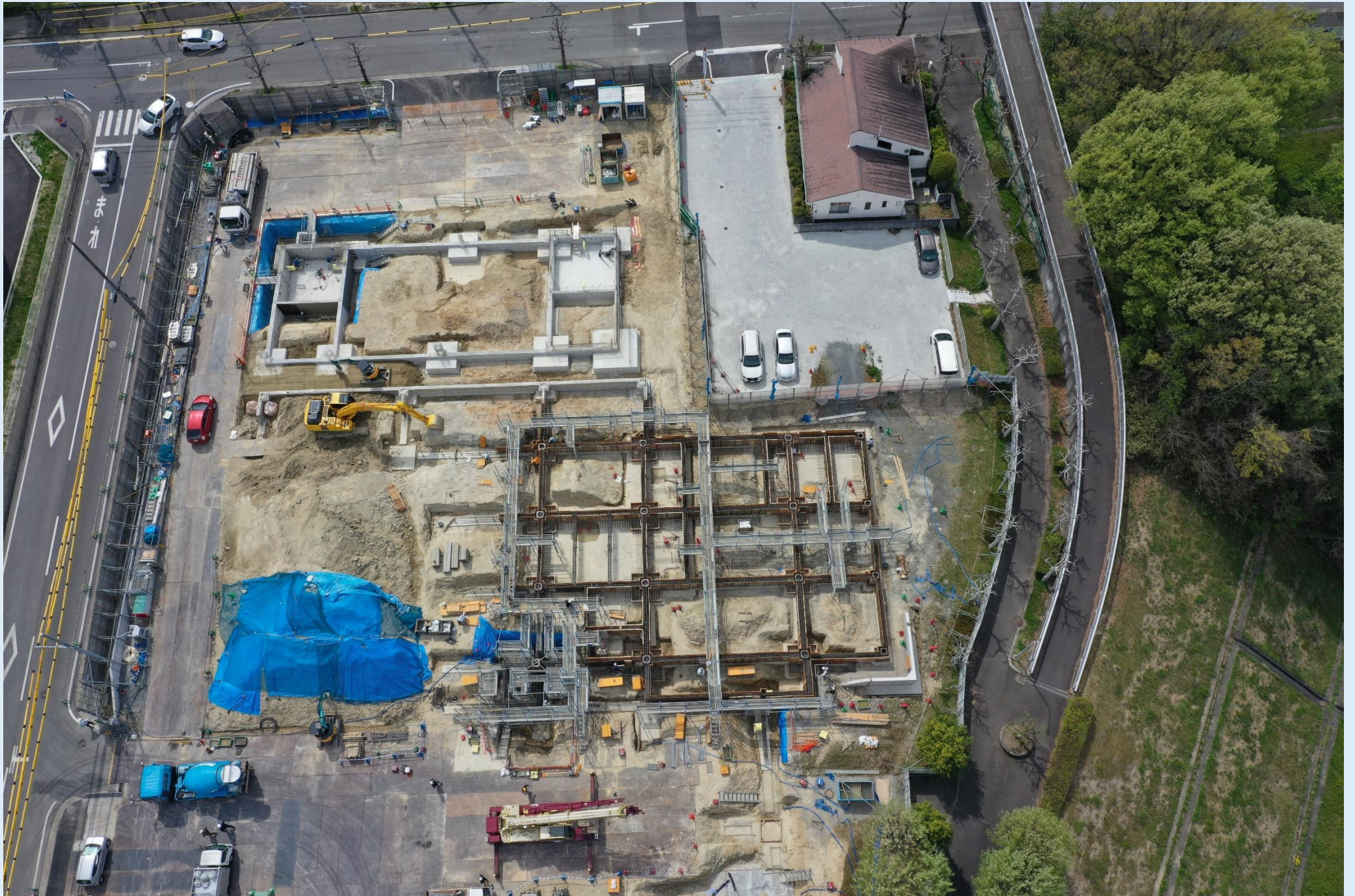
基礎工事状況 (R6.4)
