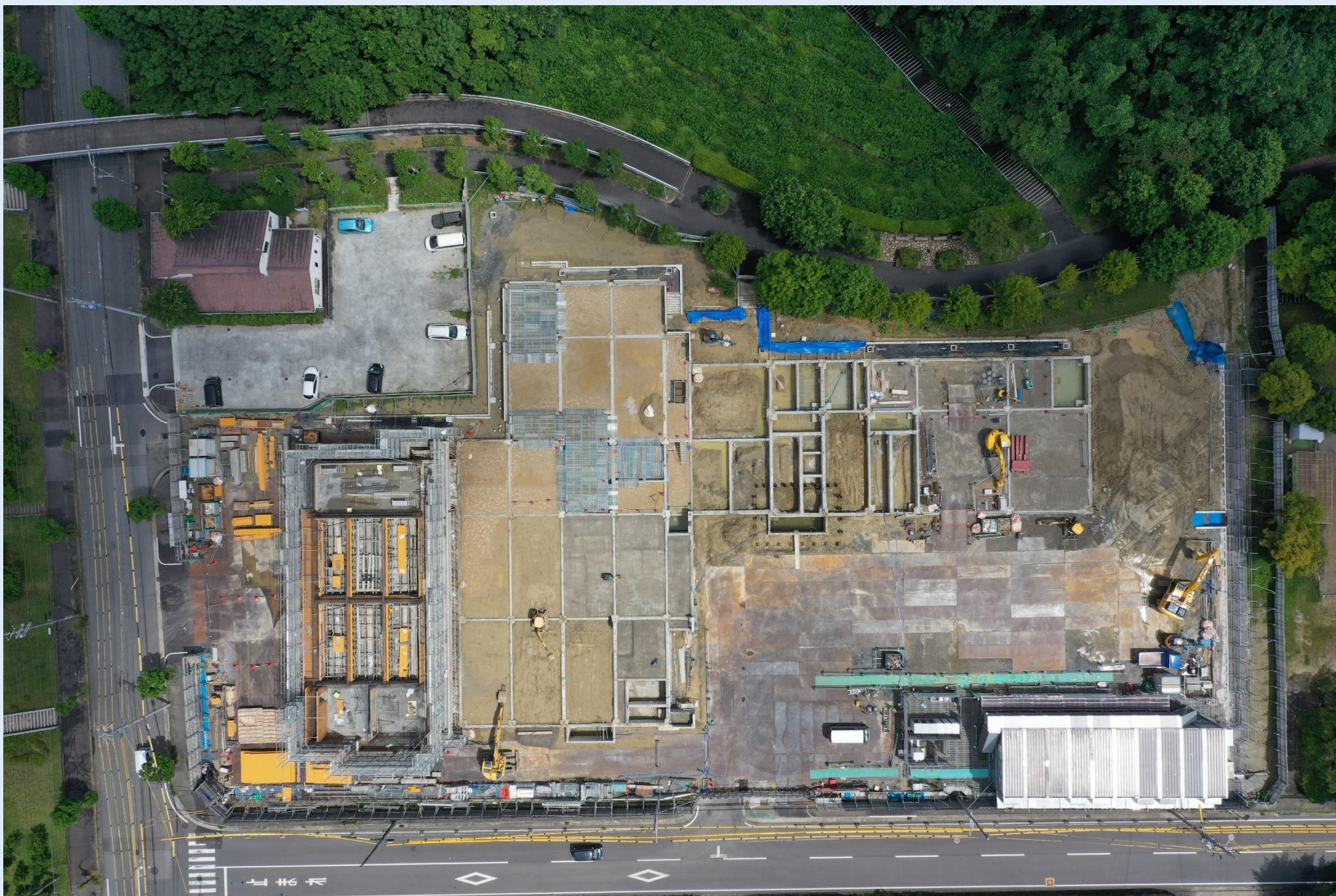
基礎工事状況 (R6.6)
