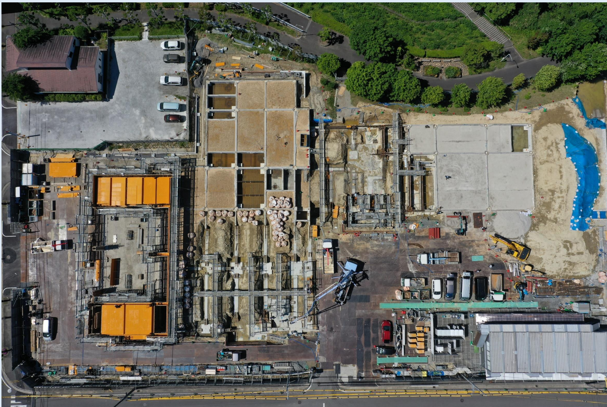
基礎工事状況 (R6.5)
