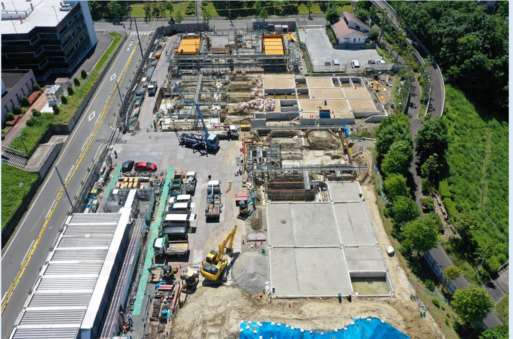
基礎工事状況 (R6.5)
