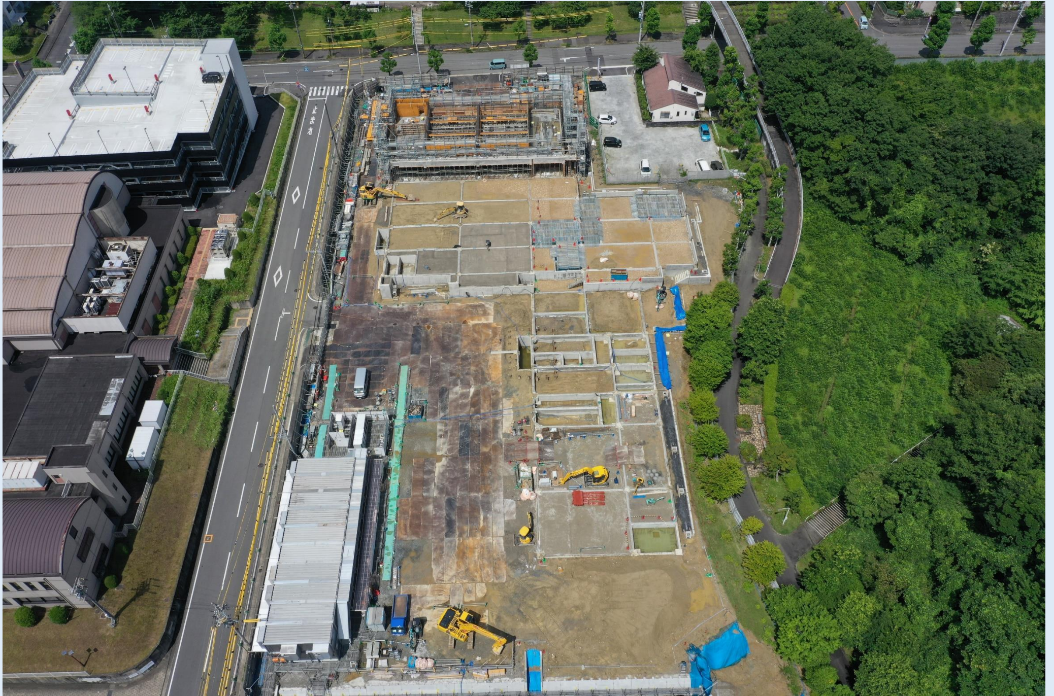
基礎工事状況 (R6.6)
