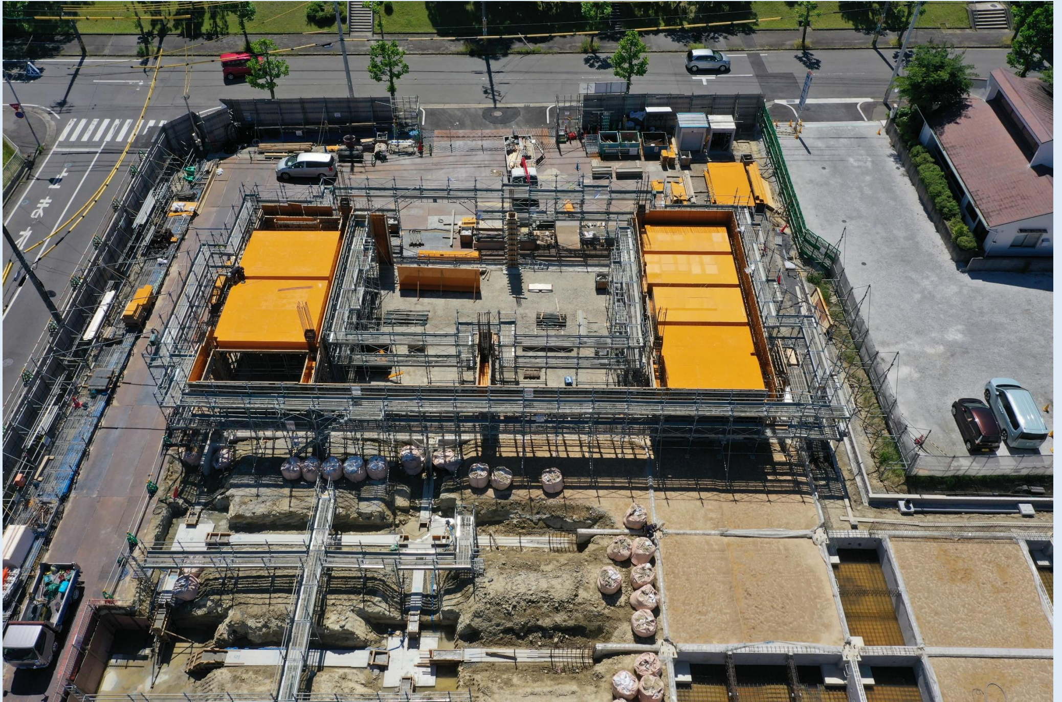
基礎工事状況 (R6.5)
