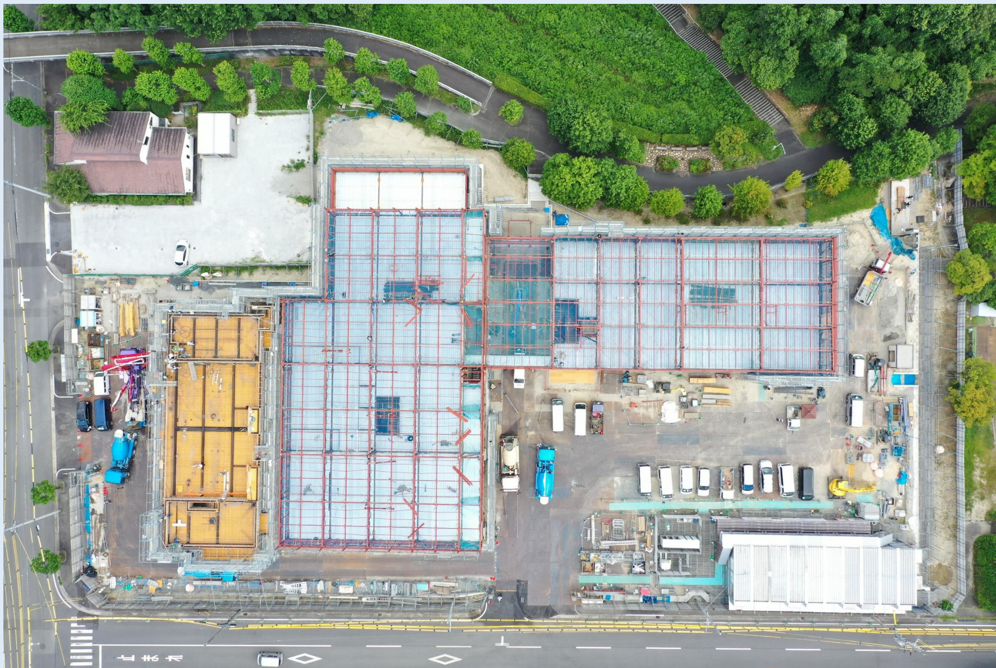
鉄骨建方工事状況 (R6.7)
