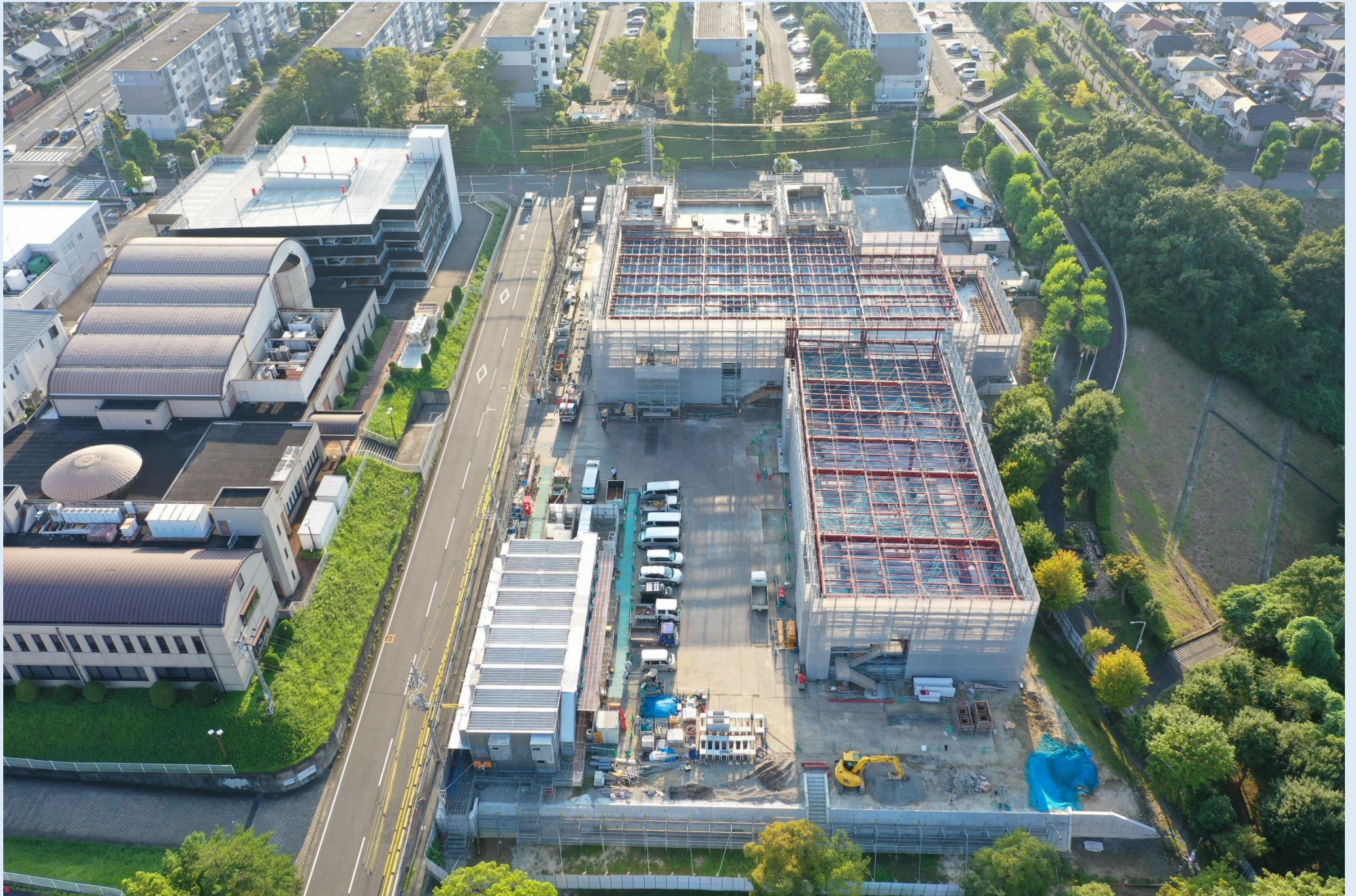
鉄骨建方工事状況 (R6.8)
