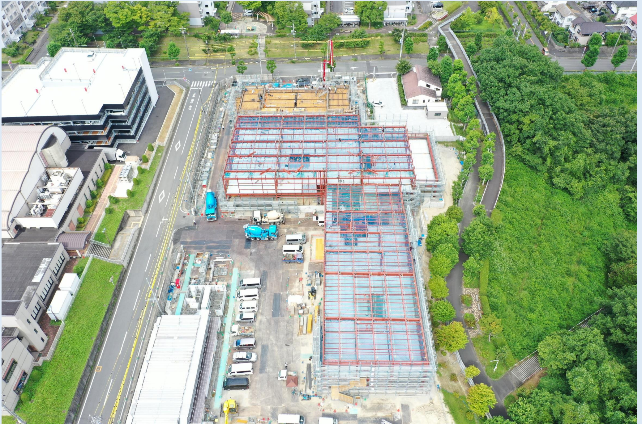
鉄骨建方工事状況 (R6.7)
