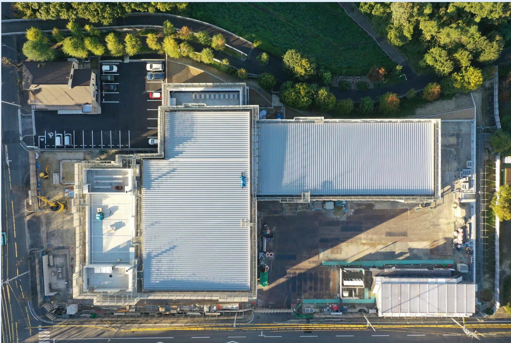
外壁屋根工事状況 (R6.10)
