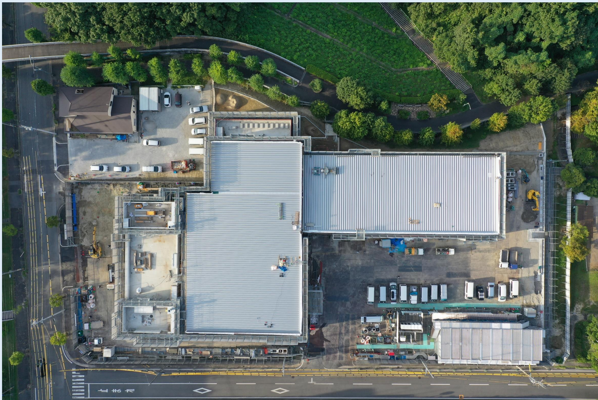
外壁屋根工事状況 (R6.9)
