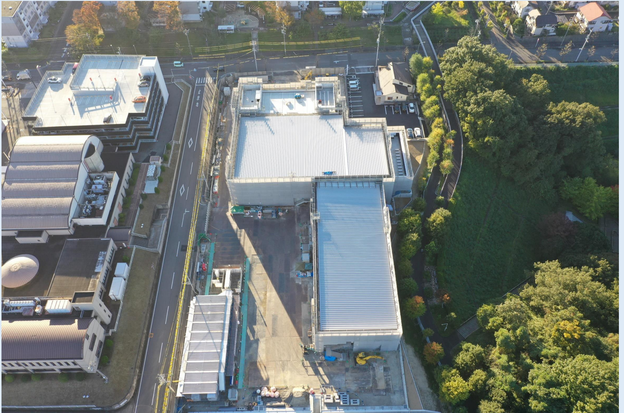
外壁屋根工事状況 (R6.10)
