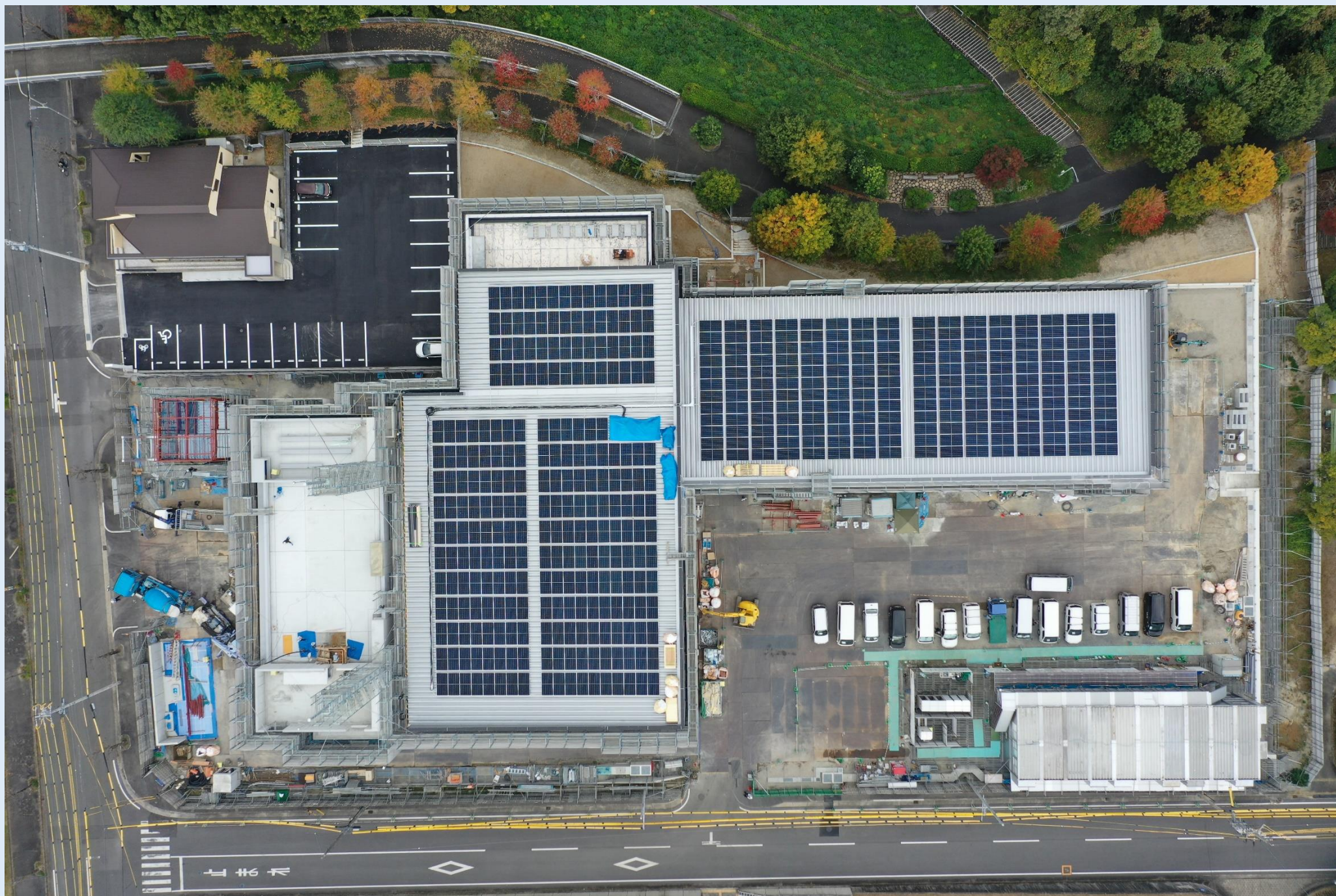
外壁屋根工事状況 (R6.11)
