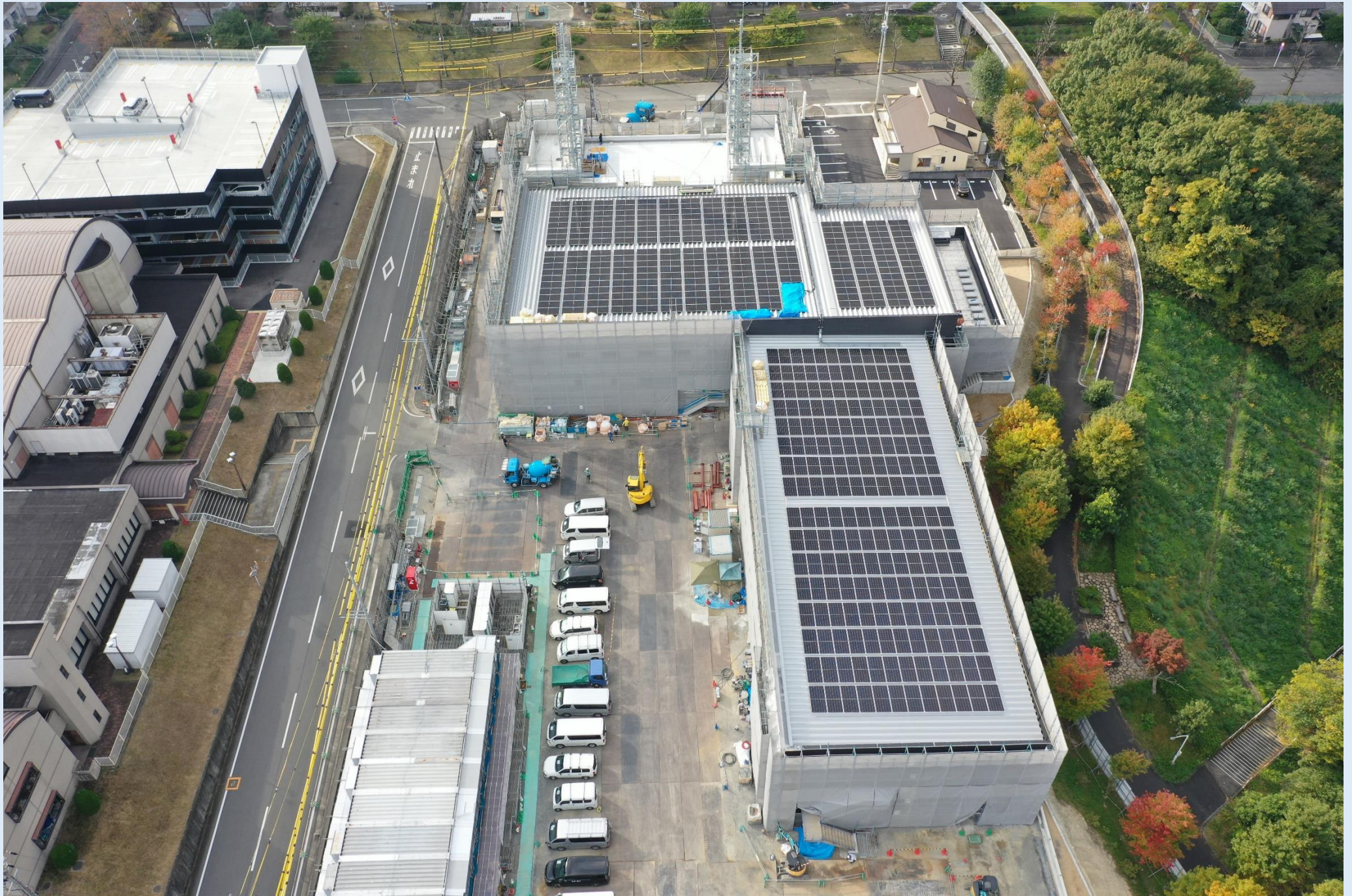
外壁屋根工事状況 (R6.11)
