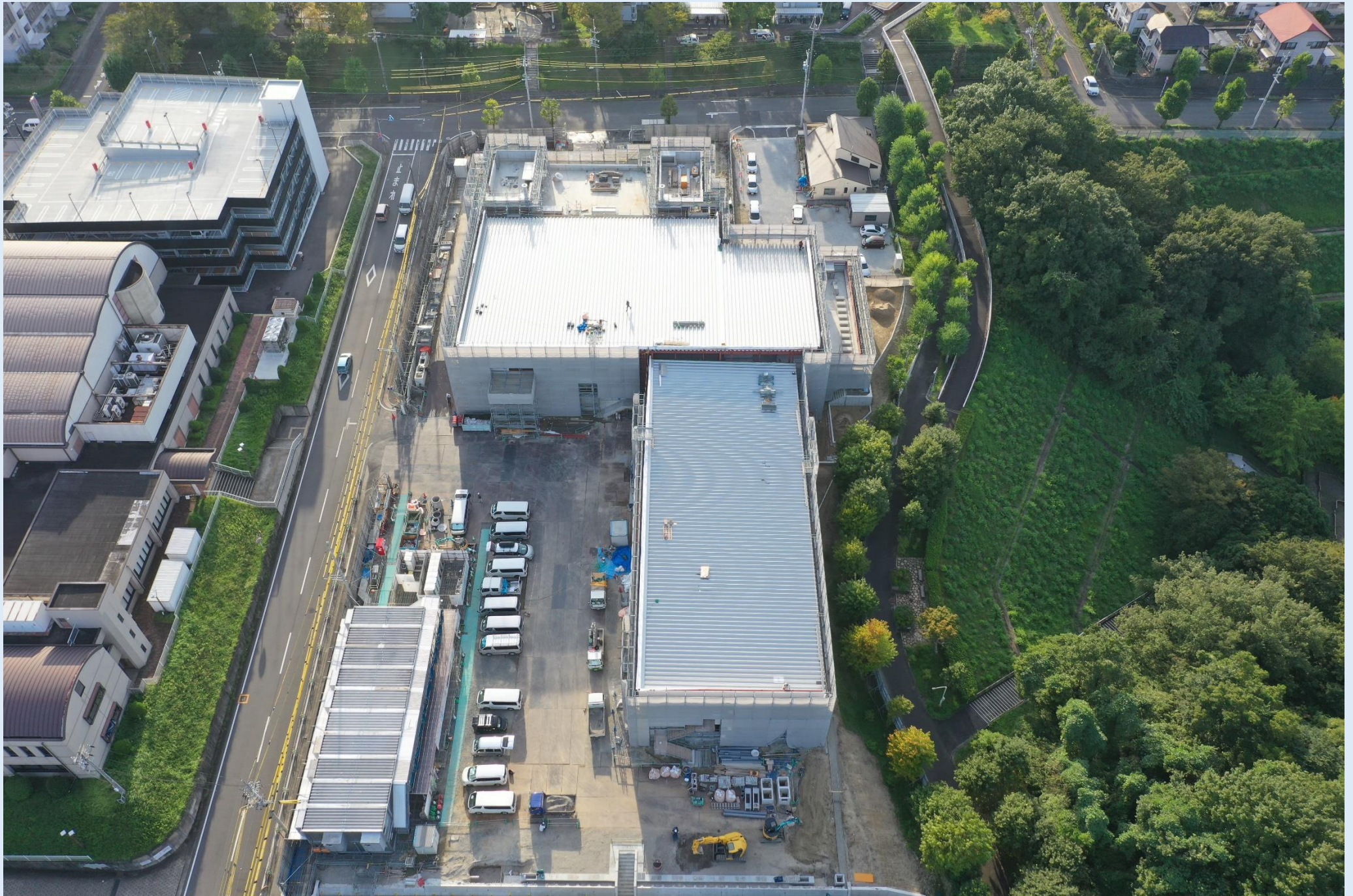
外壁屋根工事状況 (R6.9)
