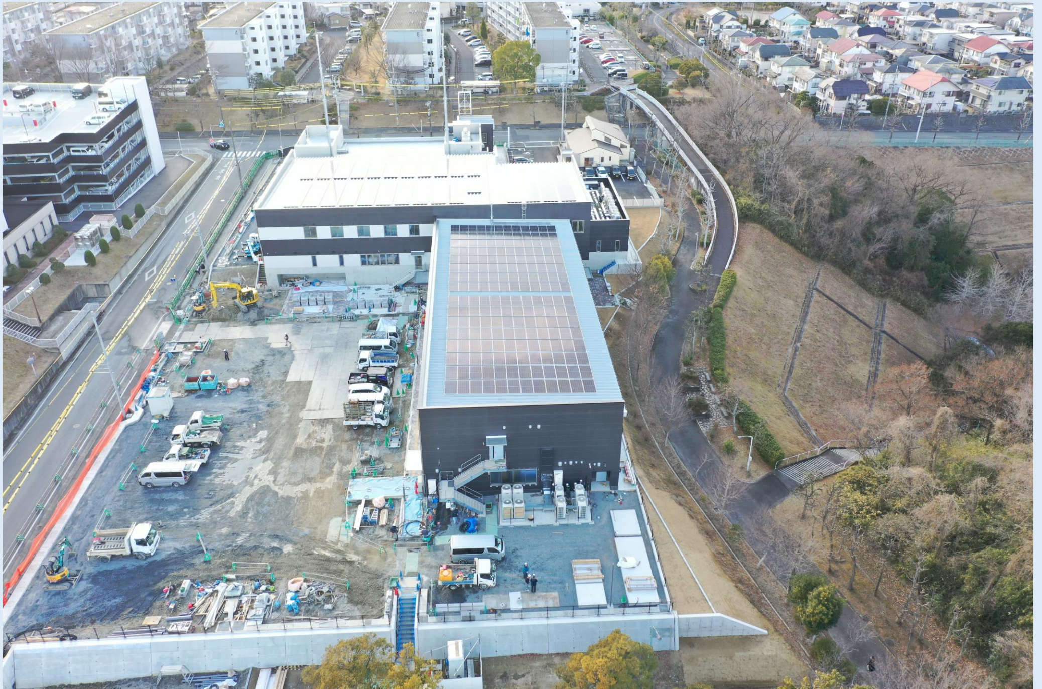
外構工事状況 (R7.1)
