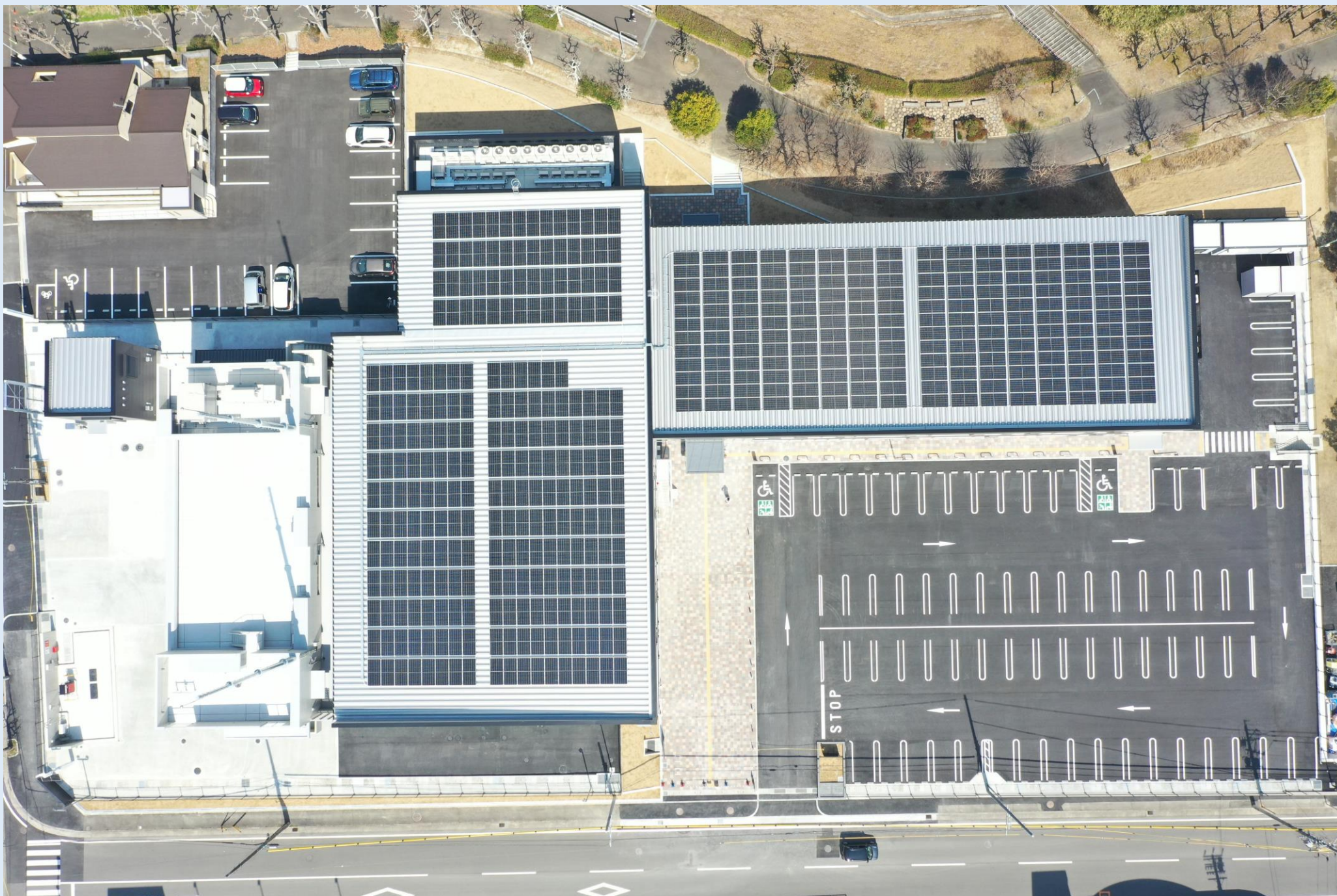
外構工事状況 (R7.3)
