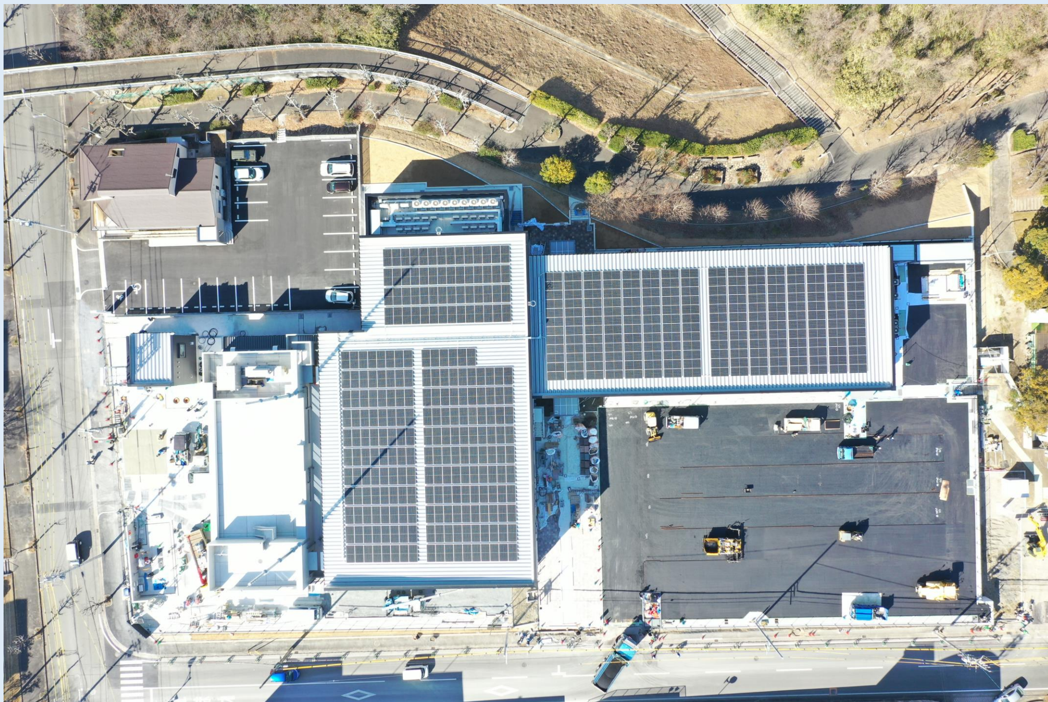
外構工事状況 (R7.2)
