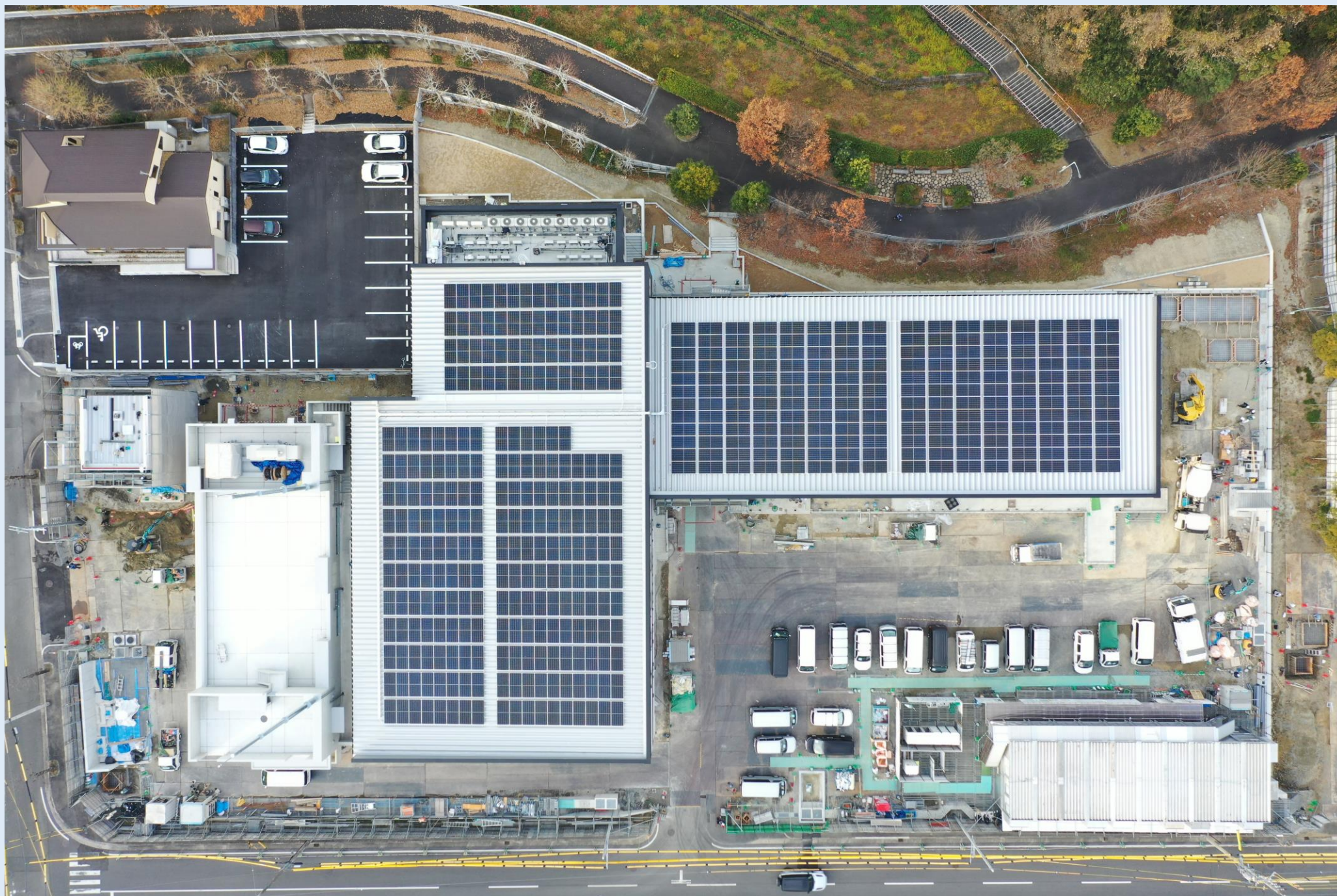
外構工事状況 (R6.12)
