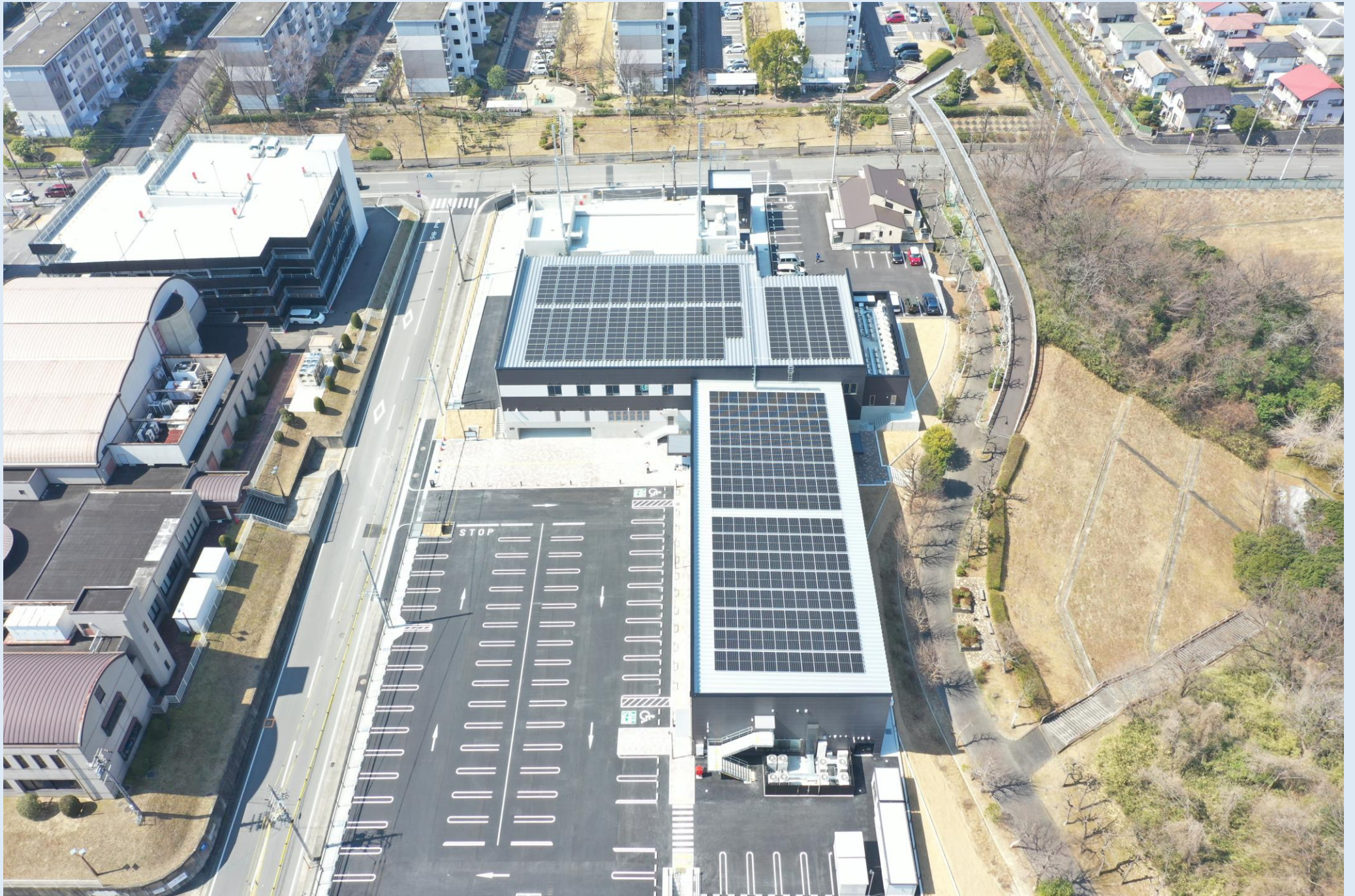
外構工事状況 (R7.3)
