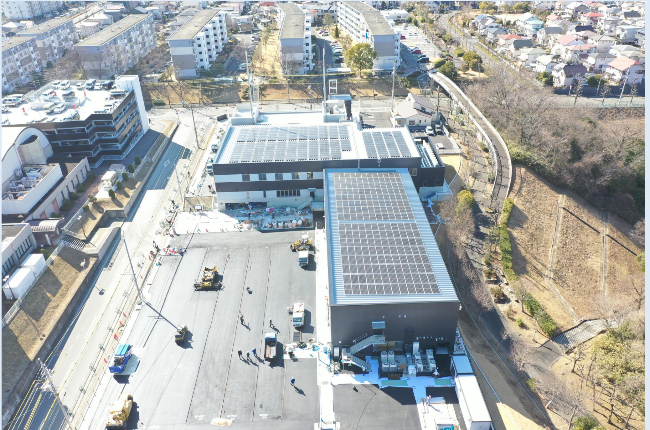
外構工事状況 (R7.2)
