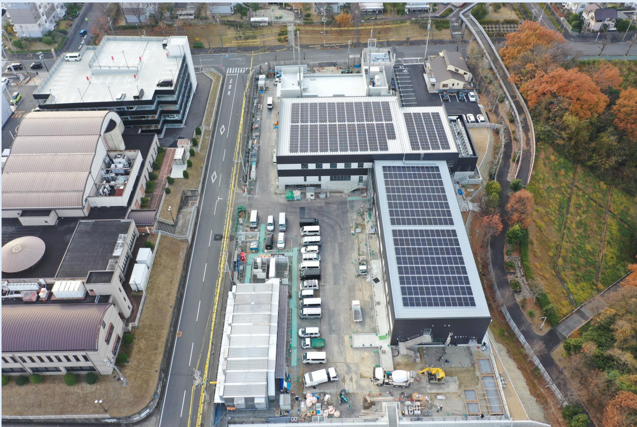
外構工事状況 (R6.12)
