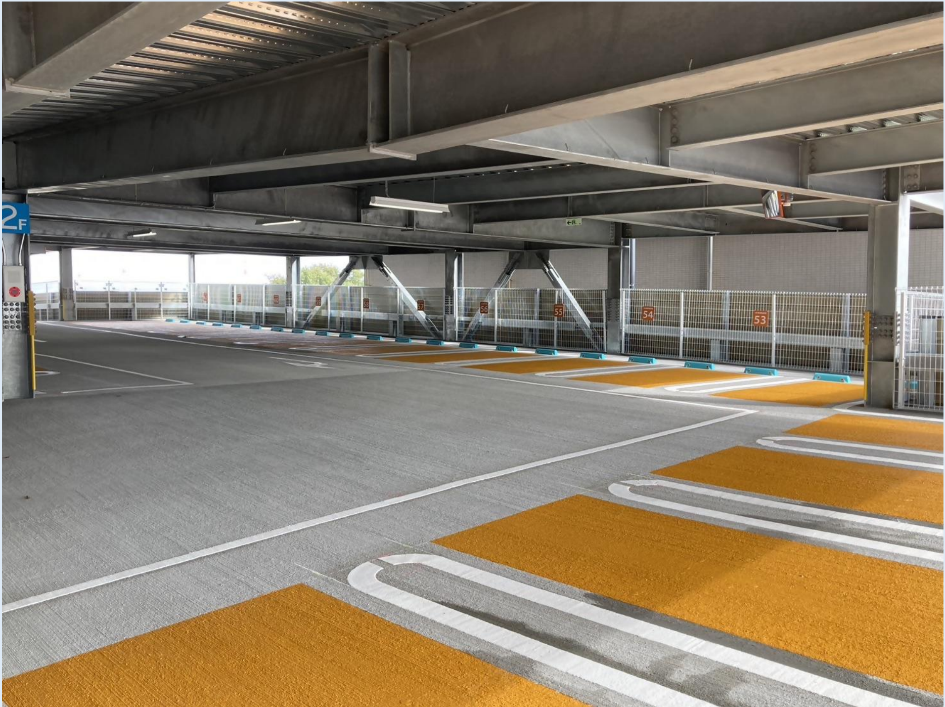
立体駐車場内部
