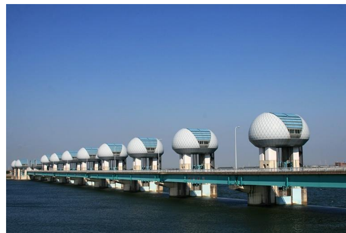
長良川河口堰（アクアプラザながら）
