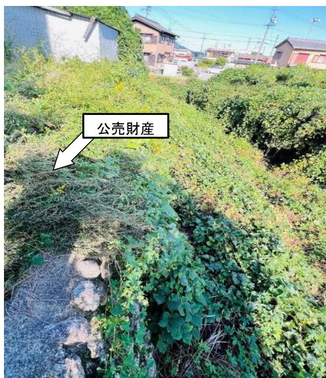
・1番23の東端部擁壁を撮影
