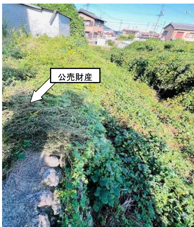
・1番23の東端部擁壁を撮影
