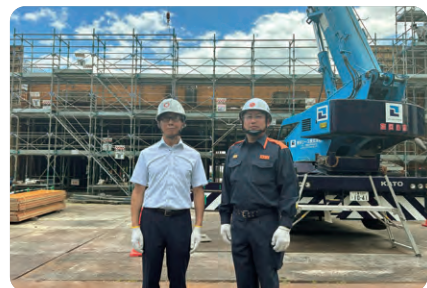
消防長(右)から新消防庁舎の建設状況を説明していただきました
