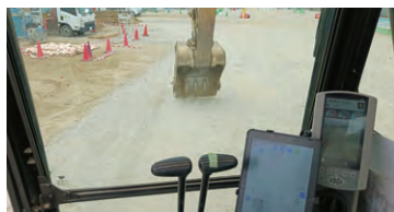
運転席に設置されたタブレットに施工箇所が映し出されます
