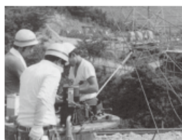
50万V基幹系統西部幹線建設(1972年完成)
