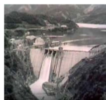
井川水力発電所(1957年)
