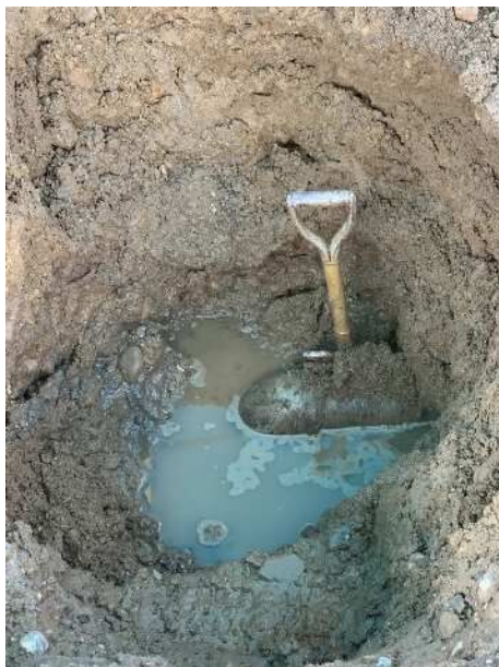
給水管の漏水
