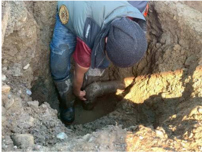
給水管の漏水
