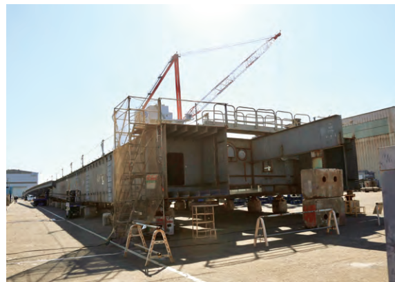
ブロックの仮組立の様子
