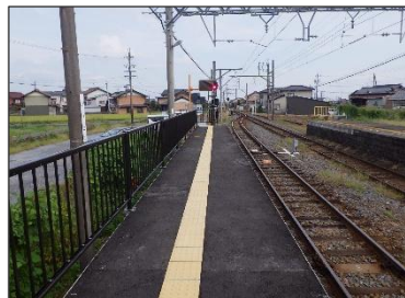
駅ホーム上(施工後)
