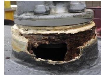
車両上部(アンテナ腐食)
