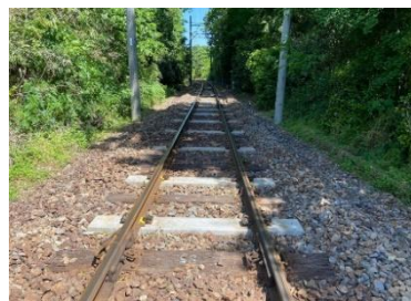
PC枕木化(施工後)
