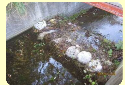
土のうによる洪水吐の嵩上げ
