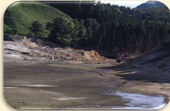
平成23年3月11日、東日本大震災により決壊した「ため池」
