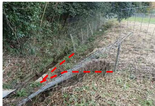
豪雨被害で倒壊・破損した侵入防止柵
