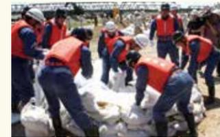
堤防近くの居住地側平場に漏水が発生しているのを、漏水の噴出口を中心に土のうを積み水を溜め、堤体土砂の流出を抑える工法です。
