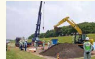
荒締め切りとは、堤防が決壊した箇所でも更なる決壊拡大や浸水を防ぐため、ブロックなどを投入し、堤防を締め切る工法です。
