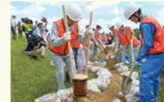
堤防の居住地側に漏水により水が吹き出し、その漏水口が拡大されるのを土のうを積んで水を溜め、堤防土砂の流出を抑える工法です。
