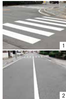
①警察が設置する横断歩道 ②市が設置する市道の区画線。令和2年度は約18キロメートルの市道の区画線を引き直しました。
