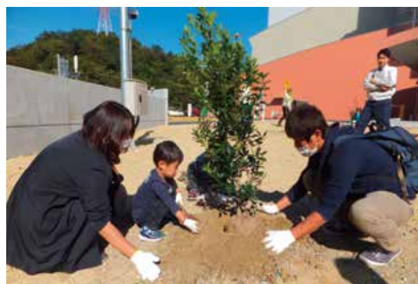
11 最新設備・技術に驚き 9 可燃ごみ焼却施設整備工事の植樹式
