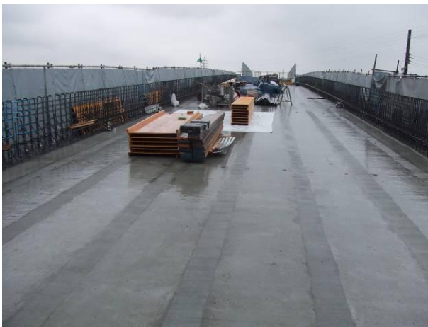
A 1 橋台～P 3 橋脚間橋面状況
