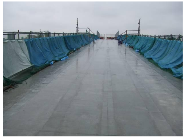
A 2 橋台～P 4 橋脚間橋面状況
