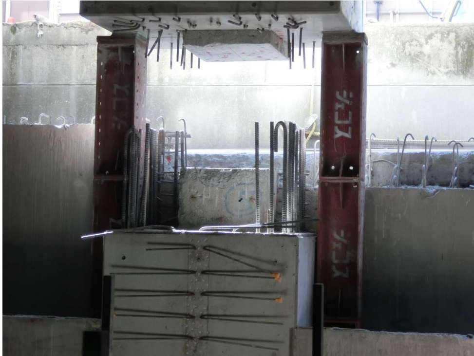
写真5：鉄筋へのキャップ取り付け状況
