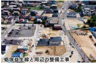
蛸塚益生線と周辺の整備工事
