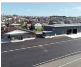
星見ヶ丘に完成した桑名市防災拠点施設。
