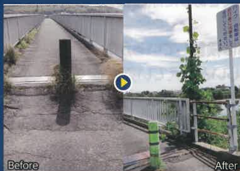
⑤ 町屋川に架かる金井橋の両端に自転車通学安全対策のため、 市に注意看板を設置、ポールを塗装していただきました
