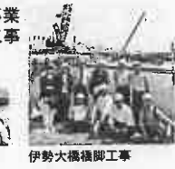
伊勢大橋橋脚工事
