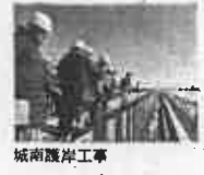
城南渡岸工事
