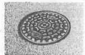
浮上防止・液化化対策が必要な 下水道マンホール
