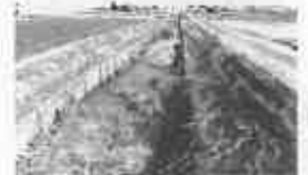
河川・排水路等浚渫・土砂撤去
