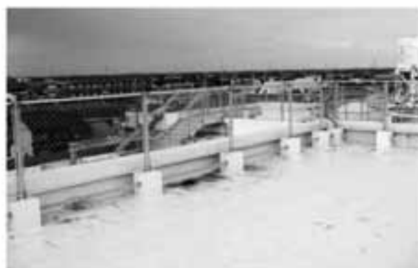
伊賀島小学校屋上フェンス
