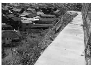
上野地区の急傾斜地
