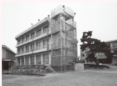
長島中部小学校避難階段設置状況
