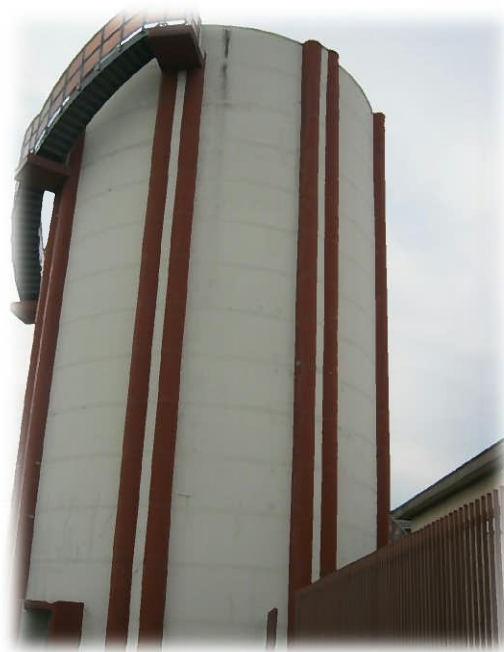
星見ヶ丘配水場 平成5年（1993）竣工
