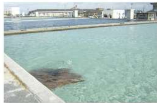
かんそく かち 緩速ろ過池
