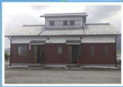
びらくく 美鹿地区 浄化センター
