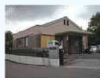
ひめぎせんおすいちゅうけい じょう ⑨姫御前汚水中継ポンプ場
