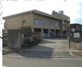
江場ポンプ場
