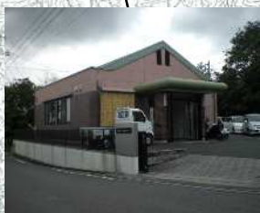
污水中継ポンプ場管理センター
