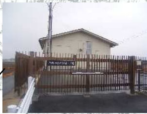
北部污水中継ポンプ場
