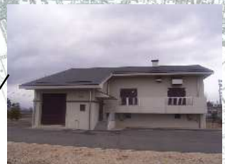
姫御前污水中継ポンプ場
