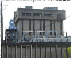
西別所ポンプ場
