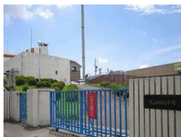
大山田配水場
