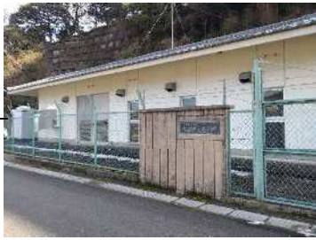
多度北部第2送水場
