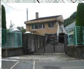
大山田第四中継ポンプ場
