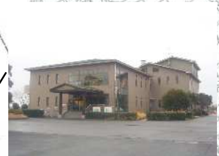
長島浄化センター(クリーンピア)
