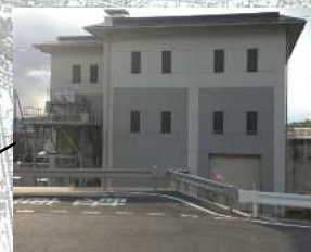
甚内ポンプ場
