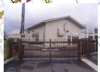
南部污水中継ポンプ場
