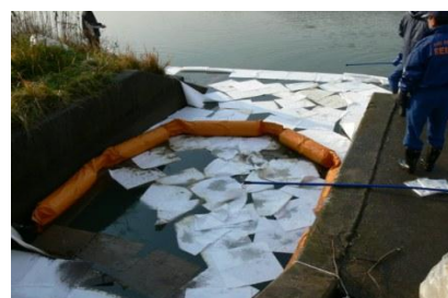
高圧洗浄の様子。
